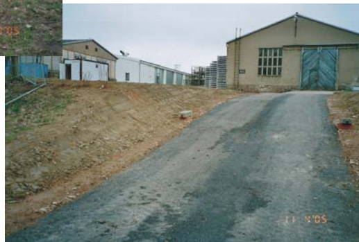
Geländegestaltung nach der Sanierung
