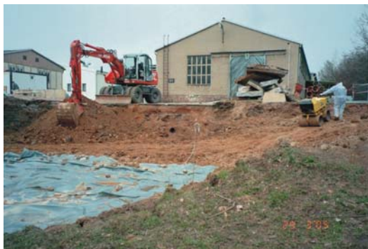
Bodenauskoffnung zur Beseitigung des Schadherdes
