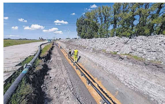
Die Baustraße neben dem Kabelgraben wurde mit besonderen Platten ausgelegt, um den Boden zu schonen.
