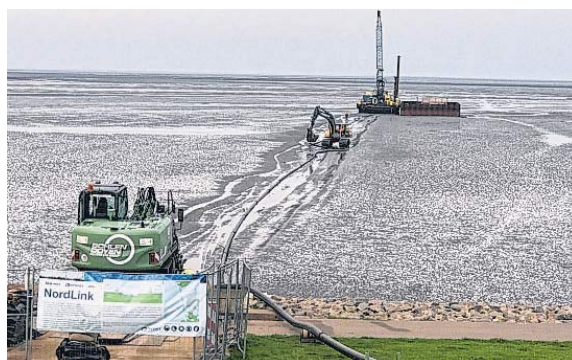
Der Landesschutzdeich wurde mit einem Horizontalspülbohrverfahren unterquert. FOTOS: FIRMA GEOS (4)
