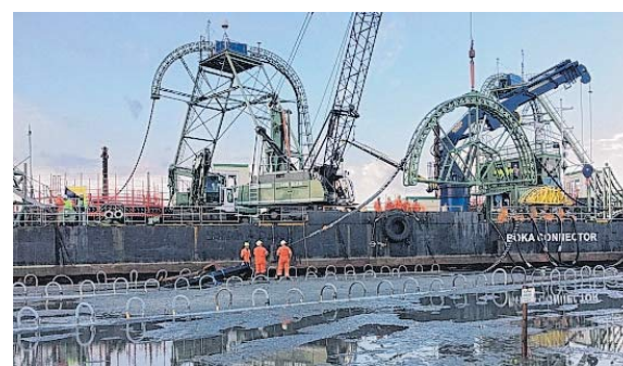
Im Wattenmeer kamen Spezialschiffe zum Einsatz. Das Seekabel ist insgesamt 516 Kilometer lang.
