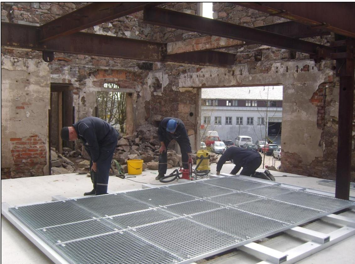
Abb.12 : Einbau der Schachtkopfabdeckung
