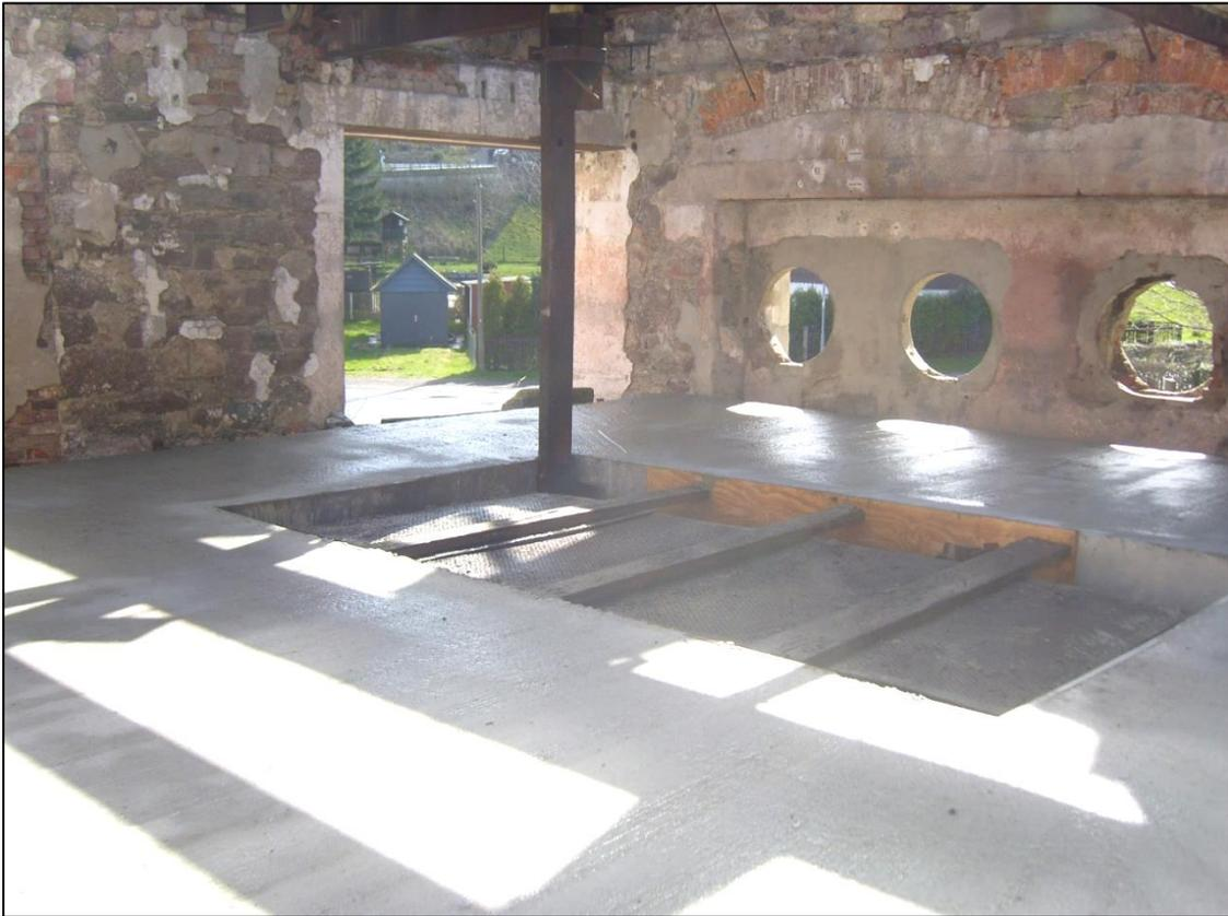
Abb.11 : Schachtkopf nach Einbau der Stahlbetonplatte
