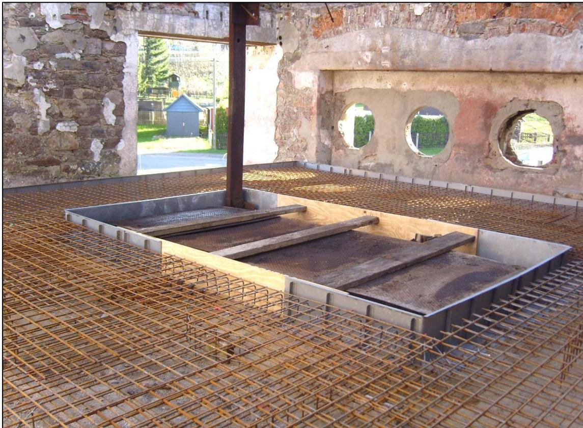
Abb.10 : Schachtkopf mit Bewehrung für die schwimmend verlegte Betonplatte
