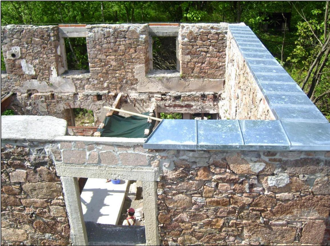
Abb.13 : Steinmetz- und Klempnerarbeiten an Gewänden und Mauerkrone
