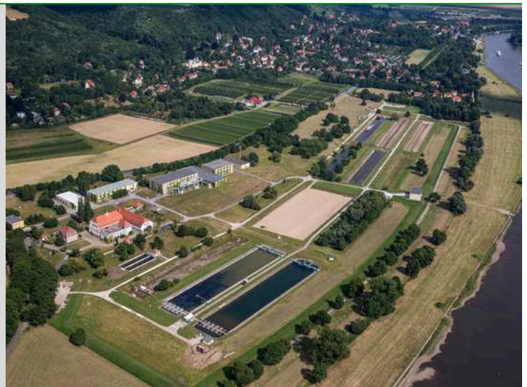
Luftbild Wasserwerk Hosterwitz (2015), © SachsenEnergie
