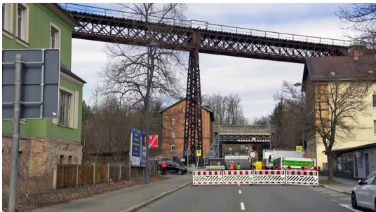
Die Durchfahrt unter dem Viadukt ist nicht möglich.
