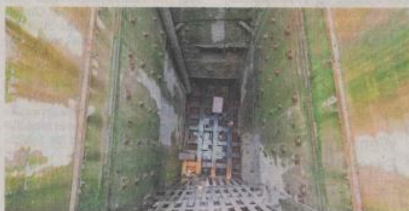
Viel Geld versenkt: Allein für die Stahlbetonplatte, die den Schacht sichern soll, werden 500 Meter Stahlträger und 800 Kubikmeter Beton benötigt. FOTO: RENE MEINIG
